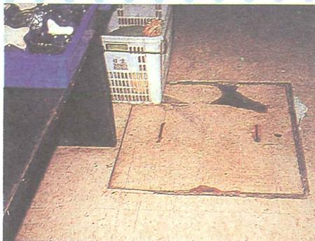
缺點：某住宅大廈變更為營業處所，為利通行，將蓄水池人孔蓋突緣打掉並堆置雜物，容易污染蓄水池水質。（資料來源：羅美棟等，建築物水塔水池對水質安全改進研究）
