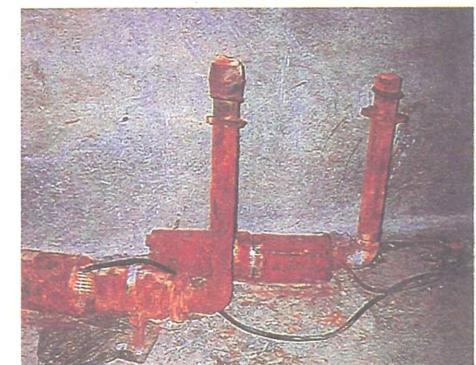
缺點：抽水馬達直接自配水管抽取用水，不僅違反法令，同時嚴重影響水質安全。（資料來源：羅美棟等，建築物水塔水池對水質安全改進研究）
