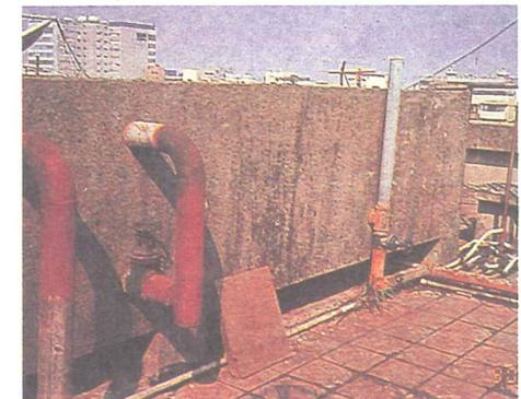
缺點：建築物水塔通氣孔、溢流管、排水管未裝設防蟲網的實例。（資料來源：羅美棟等，建築物水塔水池對水質安全改進研究）
